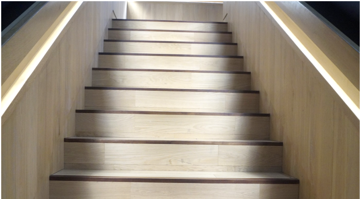
Trematerialer kan ha flere funksjoner enn å være en visuell overflate, bilde viser en trapp i heltre. Foto: NMBU
