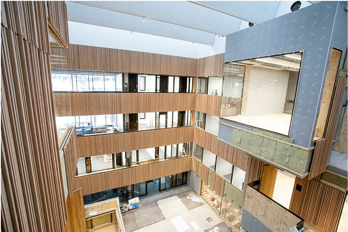
Kontor- og undervisningsfasiliteter med ekstensiv bruk av tre under bygging i veterinærbygget på NMBU. Foto: Håkon Sparre/NMBU
