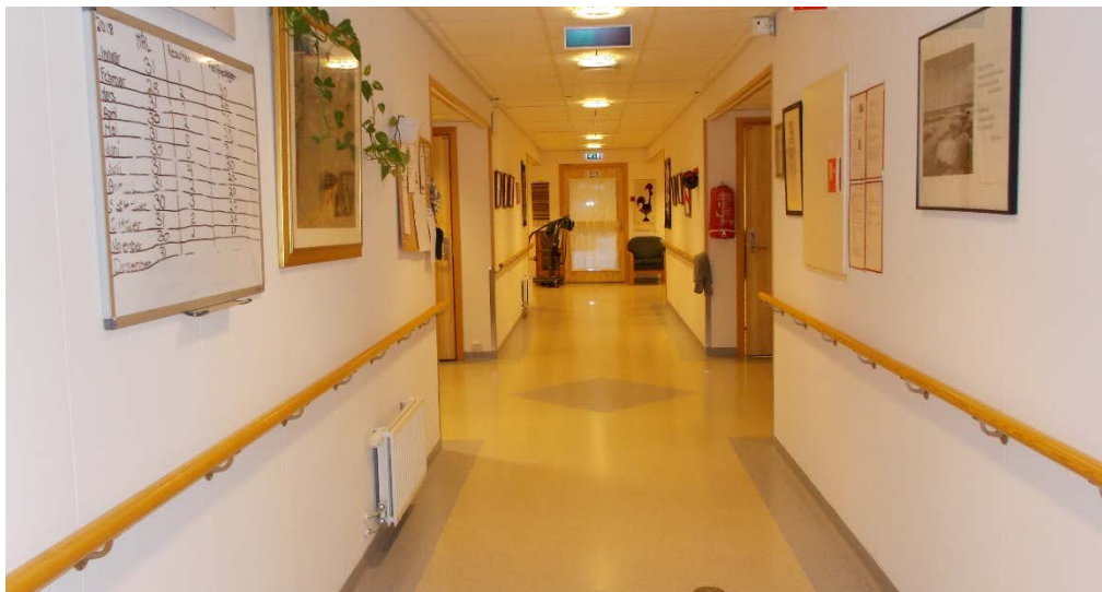
Foto 6 Rekkverk i tre, gang, Smøla sjukeheim.
