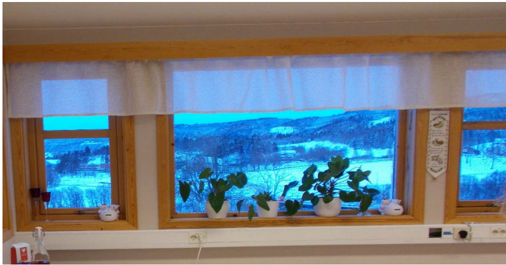
Foto 5 Vinduskarmar i tre, vaktrom, Surnadal sjukeheim.
